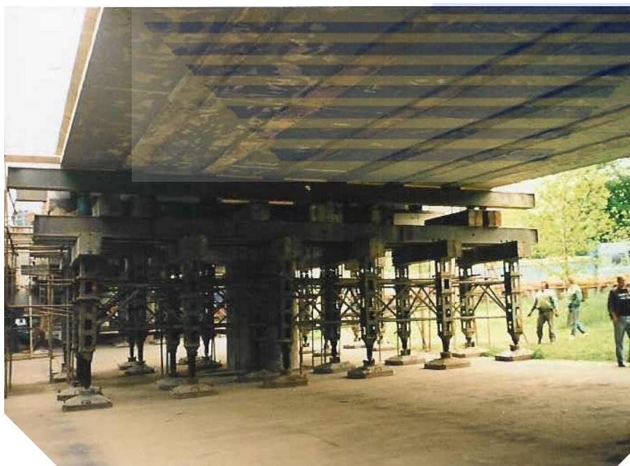
Obr. 20 Systém zvedání nosné konstrukce zdola
