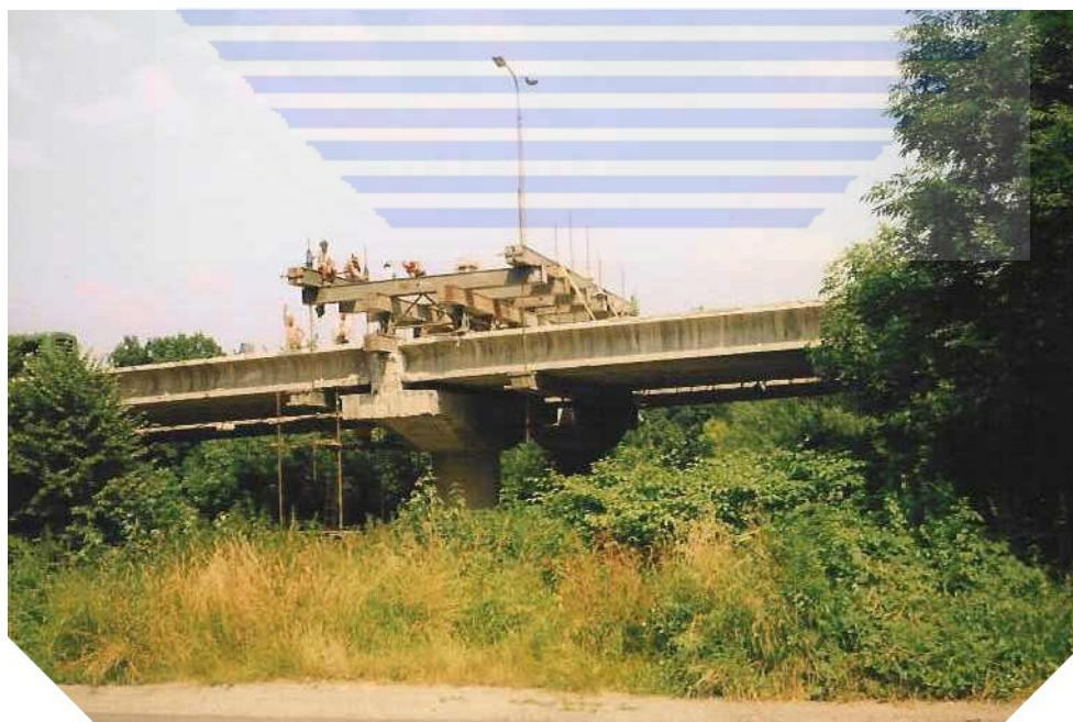
Obr. 22 Zvedání nosné konstrukce shora – Pomocné konstrukce jsou umístěny na mostě
